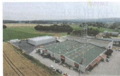
L'usine en 2018, après la construction du magasin.
